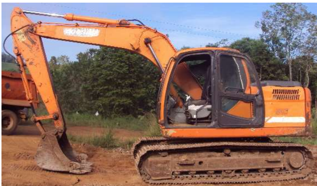
Vista parcial da escavadeira hidráulica
